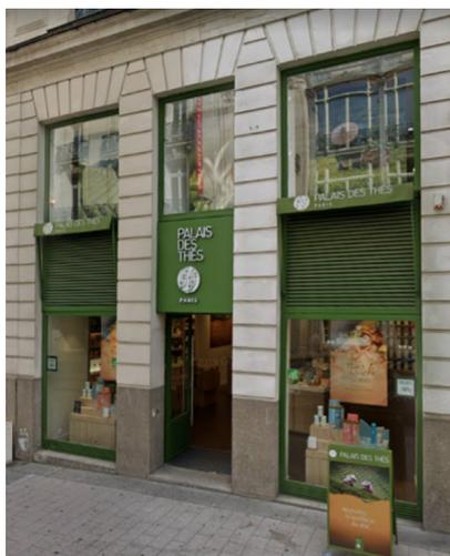
Exemple de devanture en feuillure : posée en recul par rapport à la façade en pierre, et dans l'épaisseur des murs encadrant les baies.
