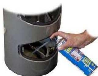
Les conduits, fourreaux, trous de maçonnerie doivent être bouchés avec de la mousse polyuréthane afin d'éviter les aspirations d'humidité par la ventilation.
